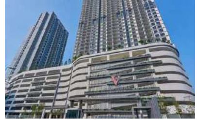
PV Vista Sentul
